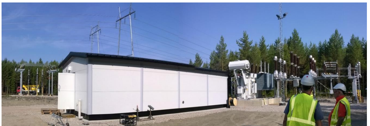
Kuva 12 . Esimerkki rakenteilla olevasta tuulivoimapuiston sähköasemasta.
